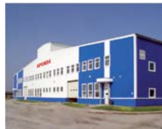
Производственный комплекс BROEN в Коломне
